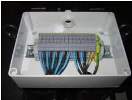
Anschlusslösung IP 65 für raue Umgebung
