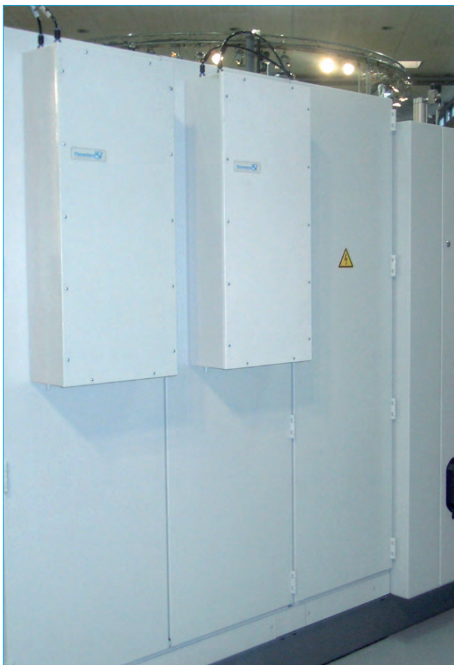
Luft-/Wasser-Wärmetauscher der Pfannenberg PWS-Baureihe
