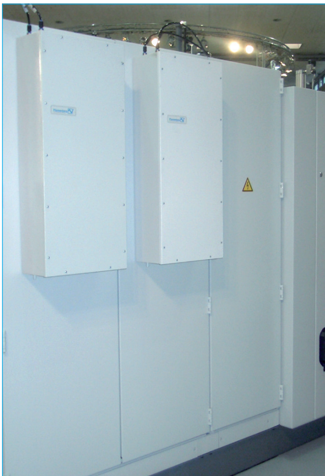
Echangeur thermique air/eau de série PWS de Pfannenberg
