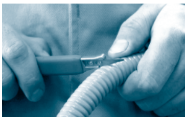
Kunststoffmantel durchtrennen (falls vorhanden) Cut the plastic mantle (if existing)
