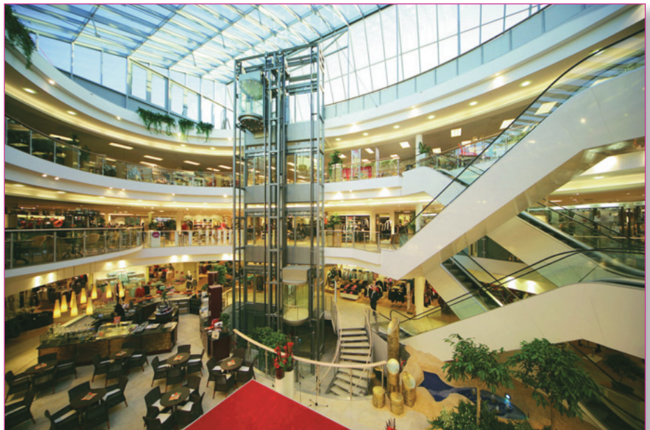
Repräsentative Aufzugsanlage in einem Einkaufszentrum
