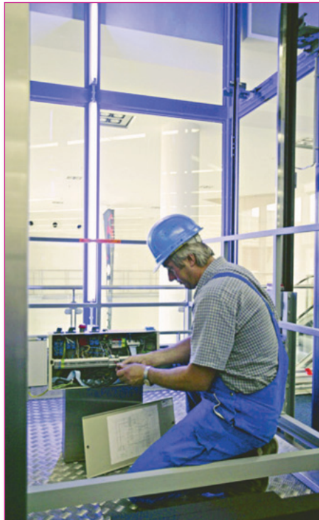
Montage der Steuerungstechnik
