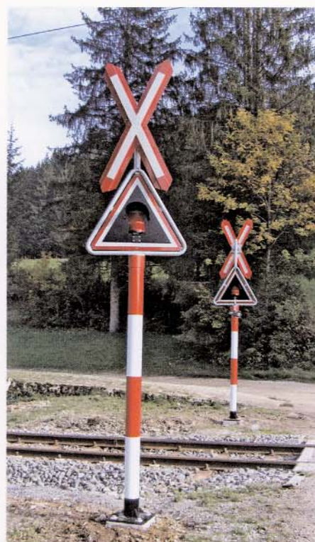
Bild 2: Blinklichtsignal mit Blitzleuchte montiert auf vorfabriziertem Betonfundament.
