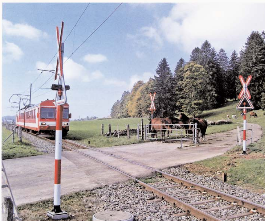
Bild 1: Bahnübergang Les Communances bei Saignelegier in den jurassischen Freibergen. Der Bahnübergang weist noch ein Viehsperre auf.
